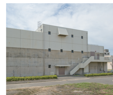
▲東部下水処理場内 再生処理施設
