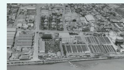
▲建設当時の福岡下水処理場 (写真提供: 高松市歴史資料館)
