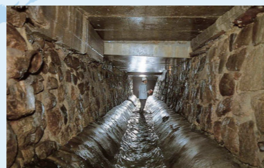
▲太閤下水 (写真提供: 大阪市建設局)
