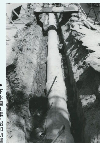
▶ 下水道工事 昭和初期 (写真提供: 高松市歴史資料館)
