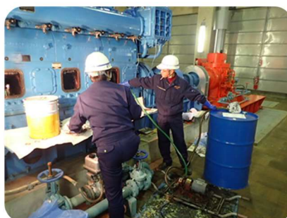
下水処理施設の維持管理状況
