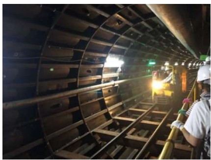
西部バイパス幹線工事現場見学（親子下水道教室）
