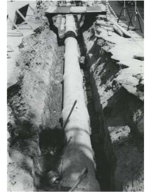
下水道工事・昭和初期
