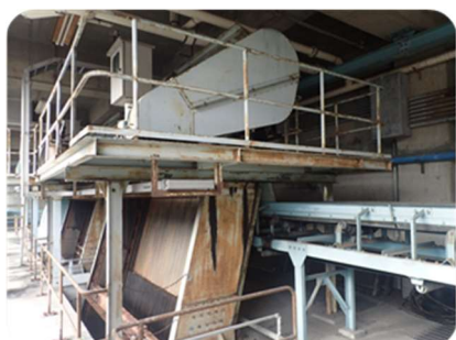
老朽化した下水処理施設
