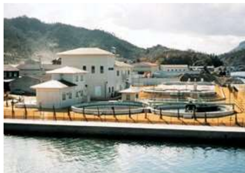
庵治浄化センター
