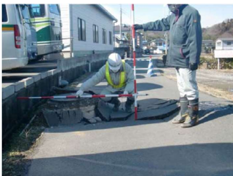
埋戻し部の液状化による管路施設の被害状況（人孔突出、栃木県真岡市）
