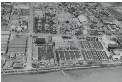
建設当時の福岡下水処理場
