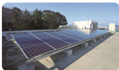
太陽光発電（東部下水処理場）
