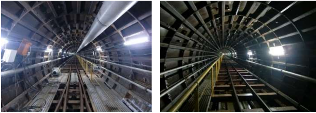
西部バイパス幹線工事現場
