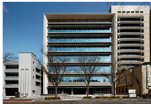
高松市防災合同庁舎(危機管理センター)
