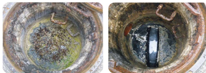
清掃前 清掃後 油脂による下水道管閉塞状況
