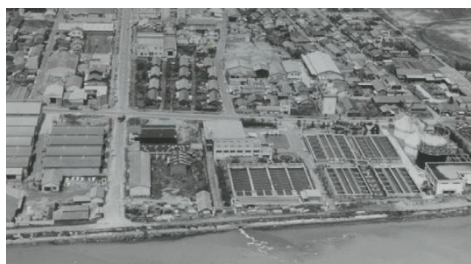
建設当時の福岡下水処理場
