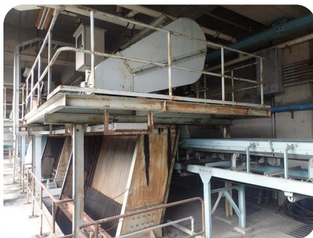
老朽化した下水処理施設
