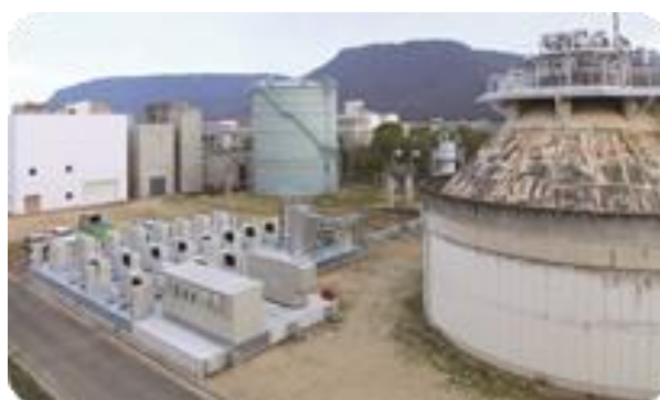
バイオマス発電（東部下水処理場）
