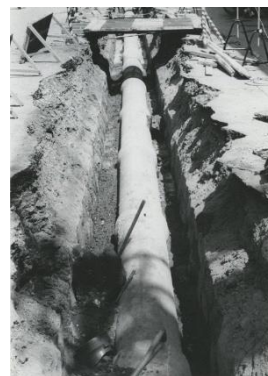
下水道工事・昭和初期
