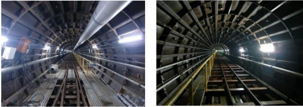
西部バイパス幹線工事現場
