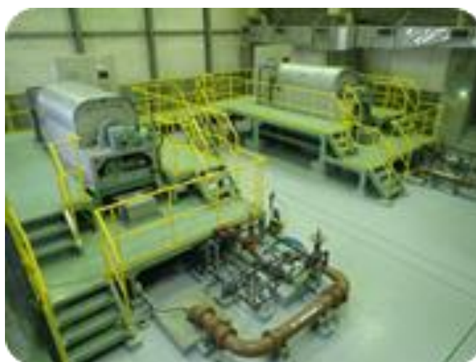
機械濃縮設備
