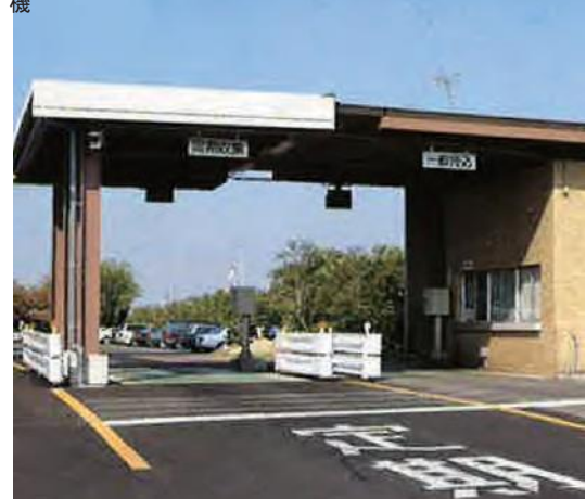
収集したごみの重量を計量しコンピュータで分類集計します。
