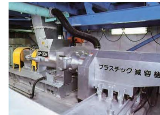
選別されたプラスチックを減容固化します。
