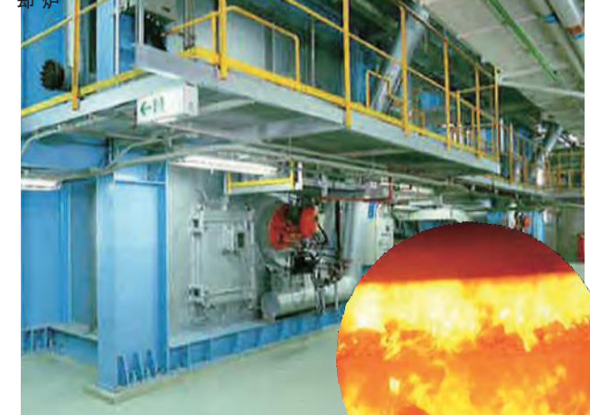
ごみは約800～950℃の高温で自動燃焼制御で完全に焼却します。
