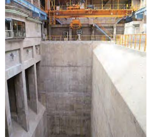
ごみピット内に一旦貯留したごみはごみクレーンで攪拌し、投入ホッパから焼却炉に投入します。
