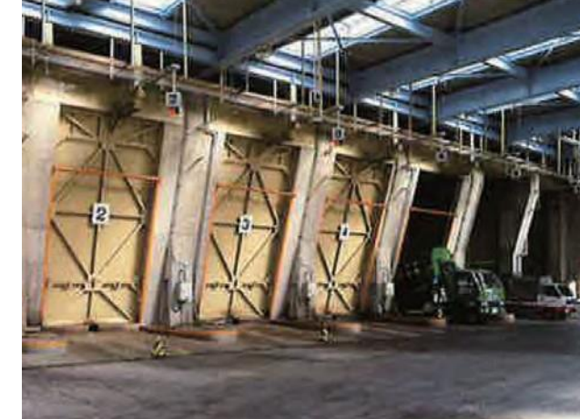
収集したごみはごみピットへ投入します。
