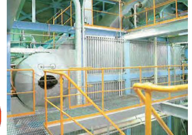
ごみ焼却で発生する熱エネルギーはボイラで蒸気に変換します。
