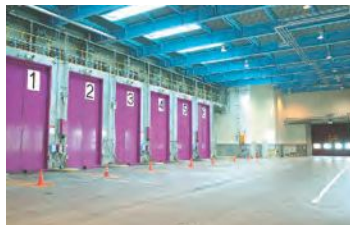
搬入されたごみをごみピットに投入します。
