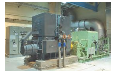
ボイラーで発生した蒸気で発電を行います。電力は南部クリーンセンター内で使用するほか、余剰電力は電力会社に送電します。
