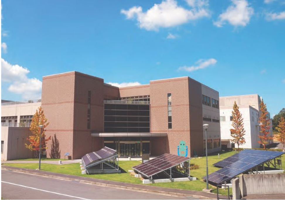
管理棟・エコホテル
