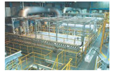
排ガス中の飛灰は、このろ過式集じん機で微細な飛灰まで取り除きます。
