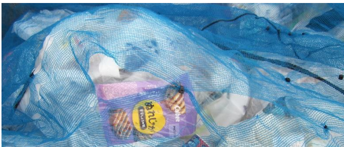
防鳥ネットが破れている
