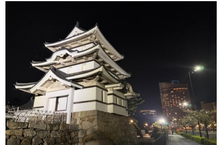
北側プロムナード照明改修工事
