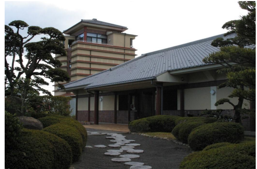
讃岐国分寺跡資料館外観
