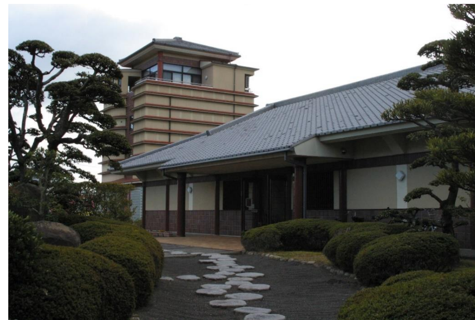
讃岐国分寺跡資料館外観
