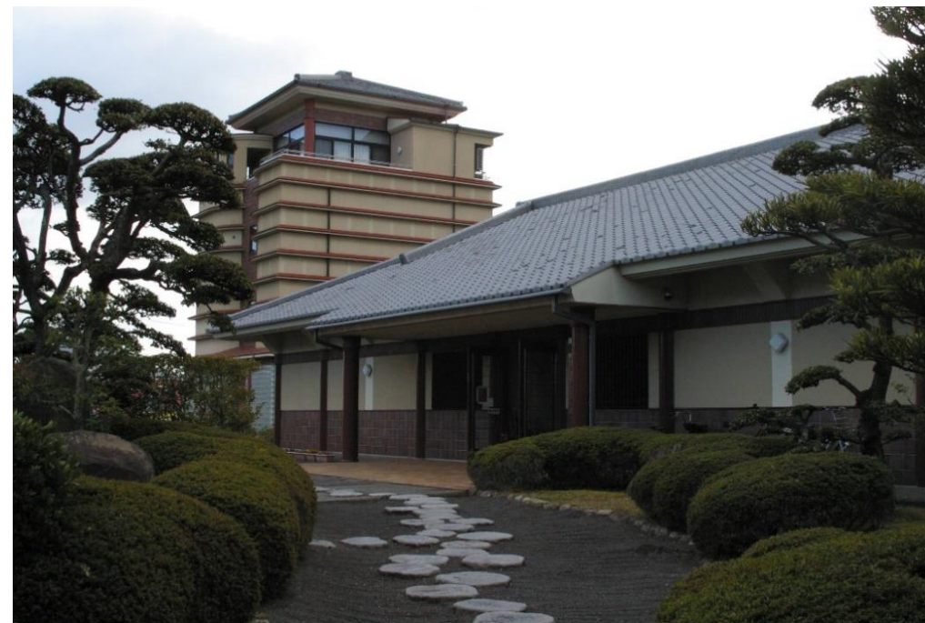
讃岐国分寺跡資料館外観
