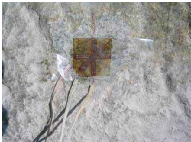
写真2 ひずみ計設置状況
