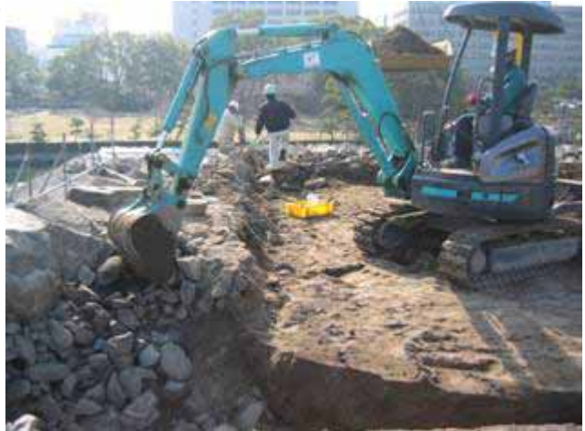
写真5 栗石掘削状況
