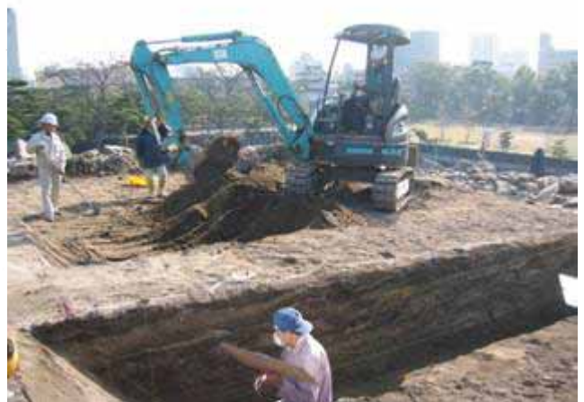
写真4 盛土掘削状況
