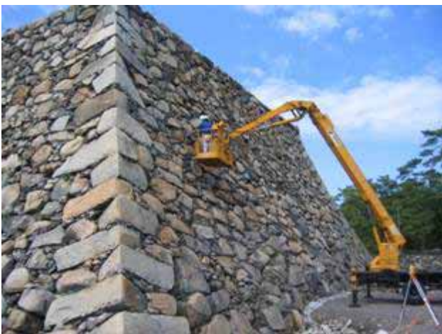
写真1 番付・墨打・外観調査状況
