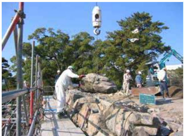
写真7 石垣解体状況
