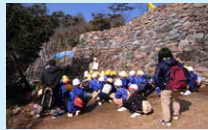
▲屋島山上にある屋嶋城の城門跡復元工事を見学している様子
