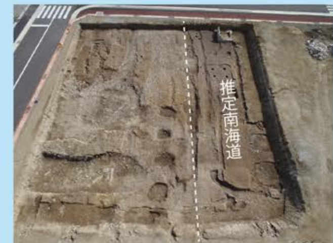
② 南海道の側溝?
