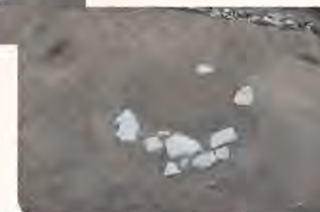
写真7 残された根石(礎石を支える石)
