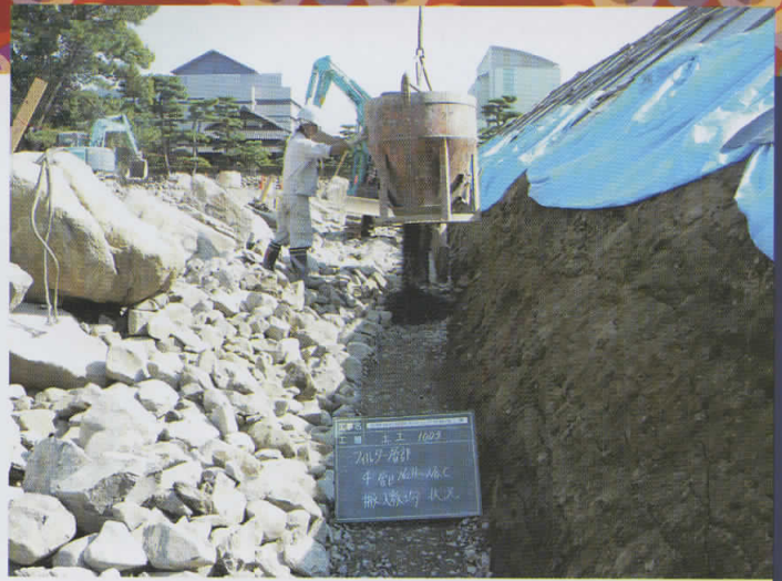
吸出し防止層の施工状況
