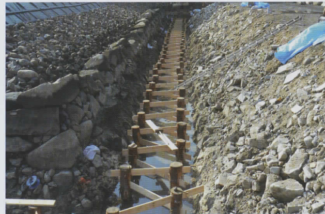
杵工の施工状況
