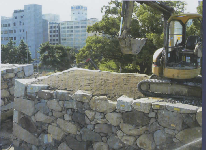
石垣天端の排水用盛土
