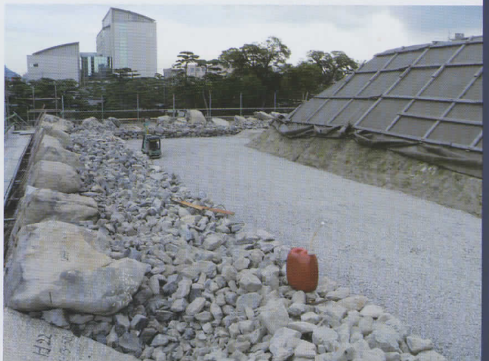
排水層の施工状況
