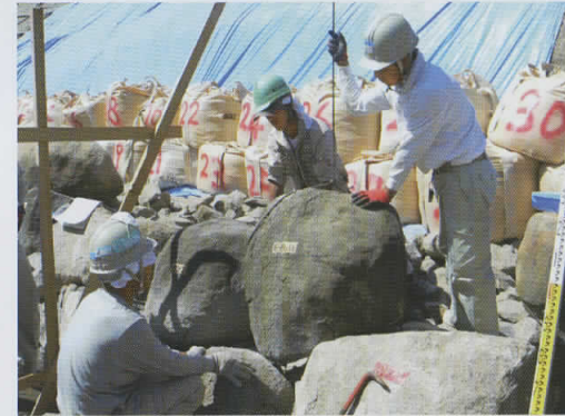
クレーンを用いて石材を据える石工
