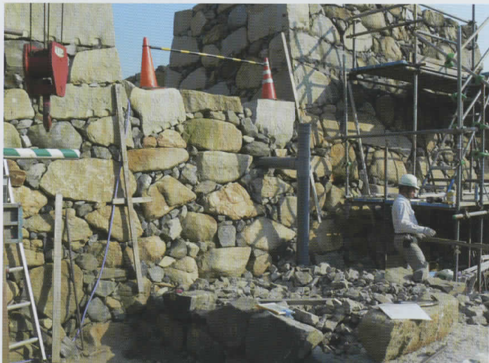
集水枘・排水管の新設状況
