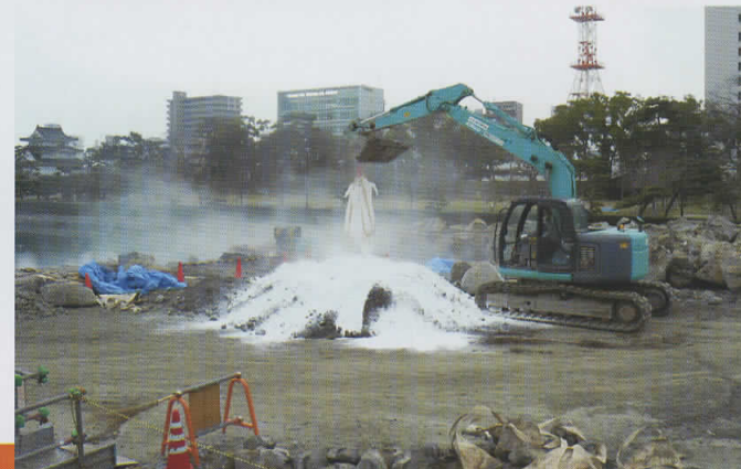
盛土と石灰の混和状況
