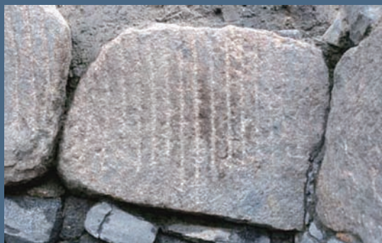
上写真 確認した中堀石垣の表面に見られるスタレ状の加工痕
