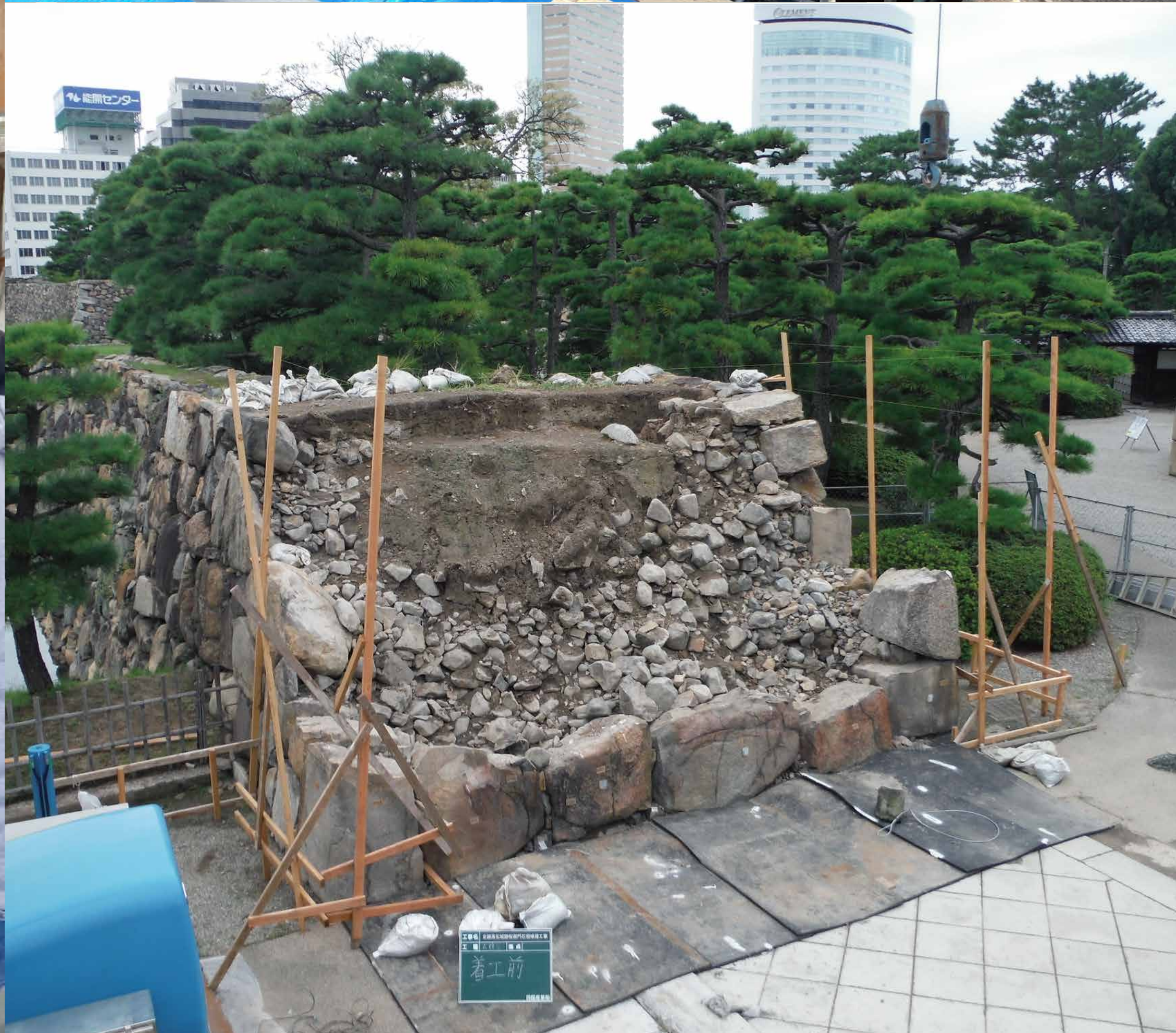
いしがき 石垣解体修理
