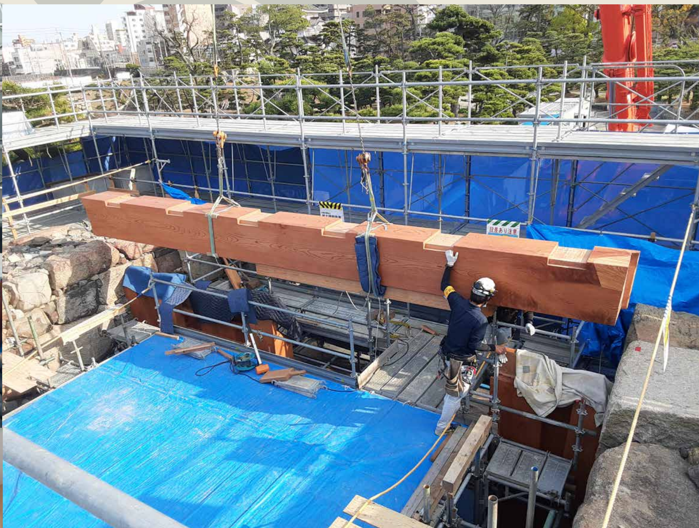
かぶき 柱と冠木の組立て
