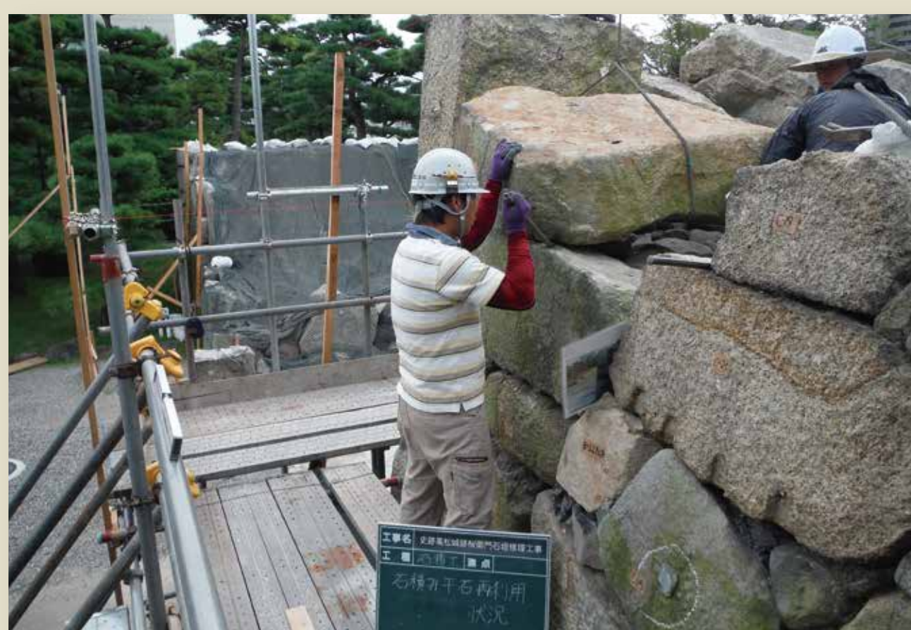
■石牆的拆除修理
