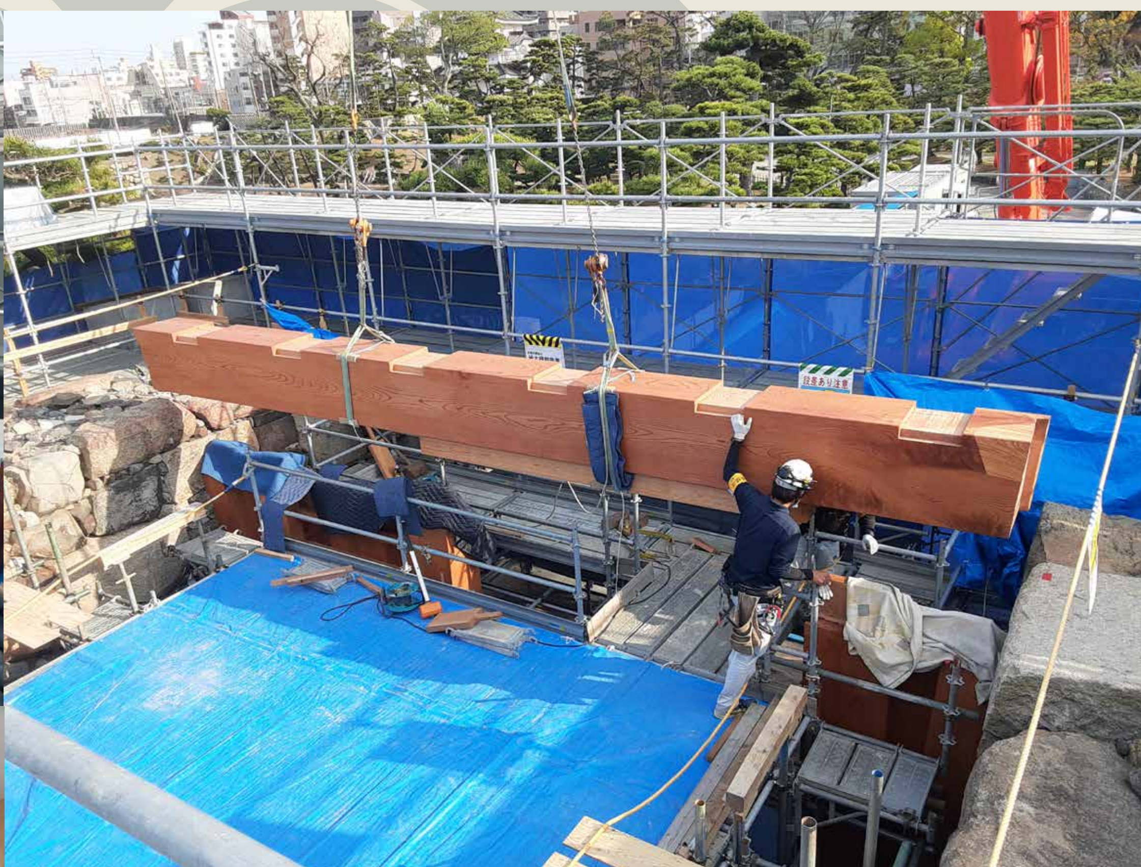
かぶき 柱と冠木の組立て
