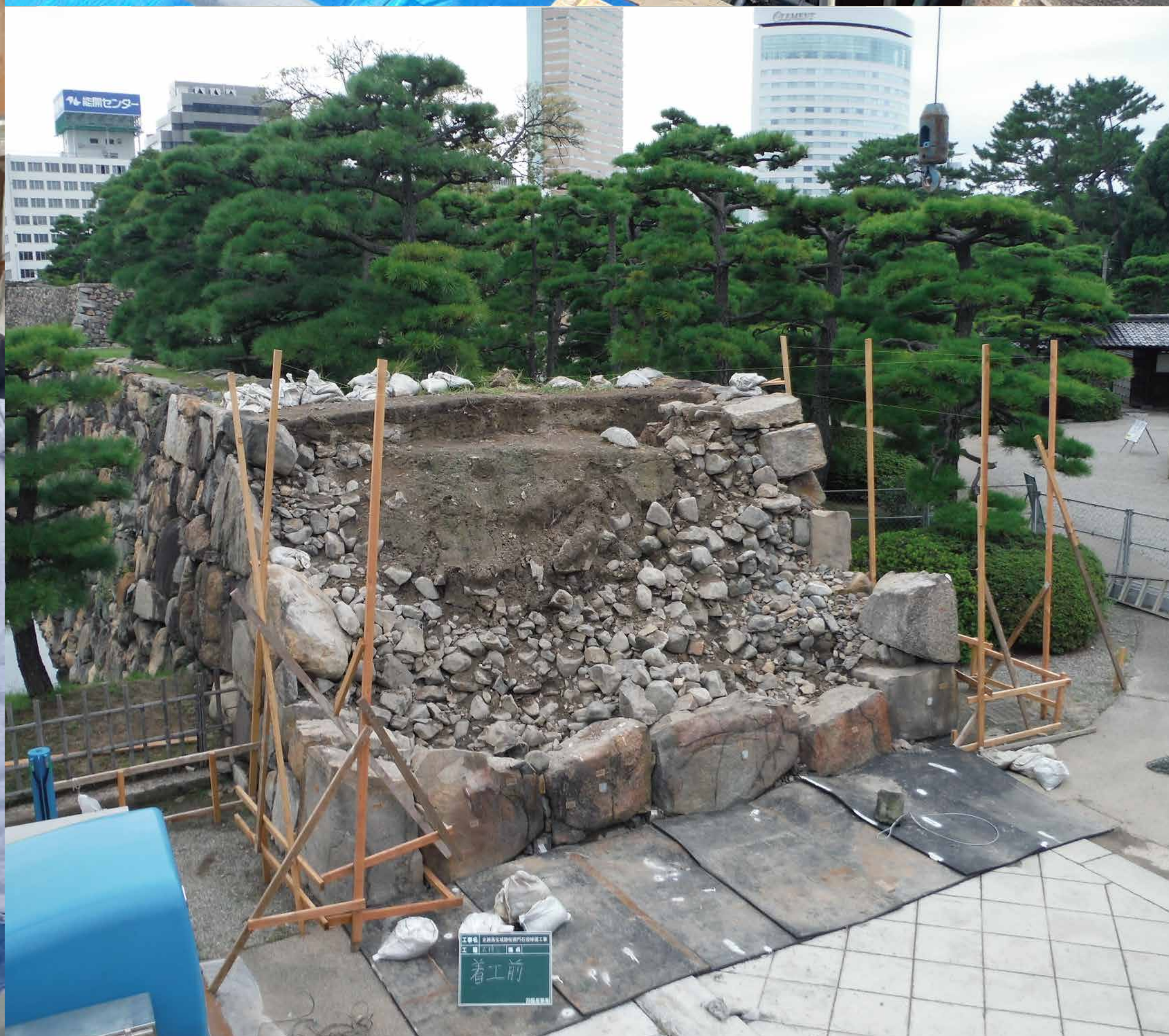
いしがき 石垣解体修理
