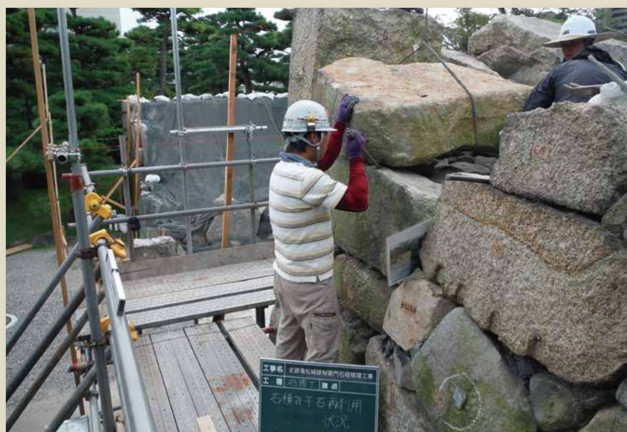
■石墙的拆除修理
