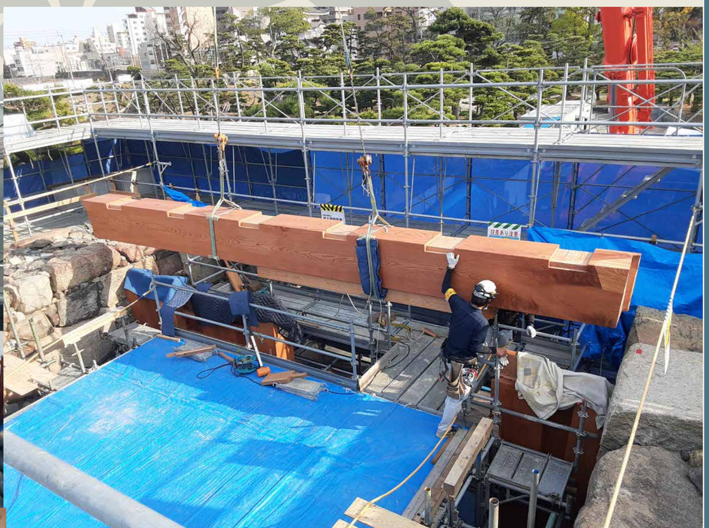
かぶき 柱と冠木の組立て
