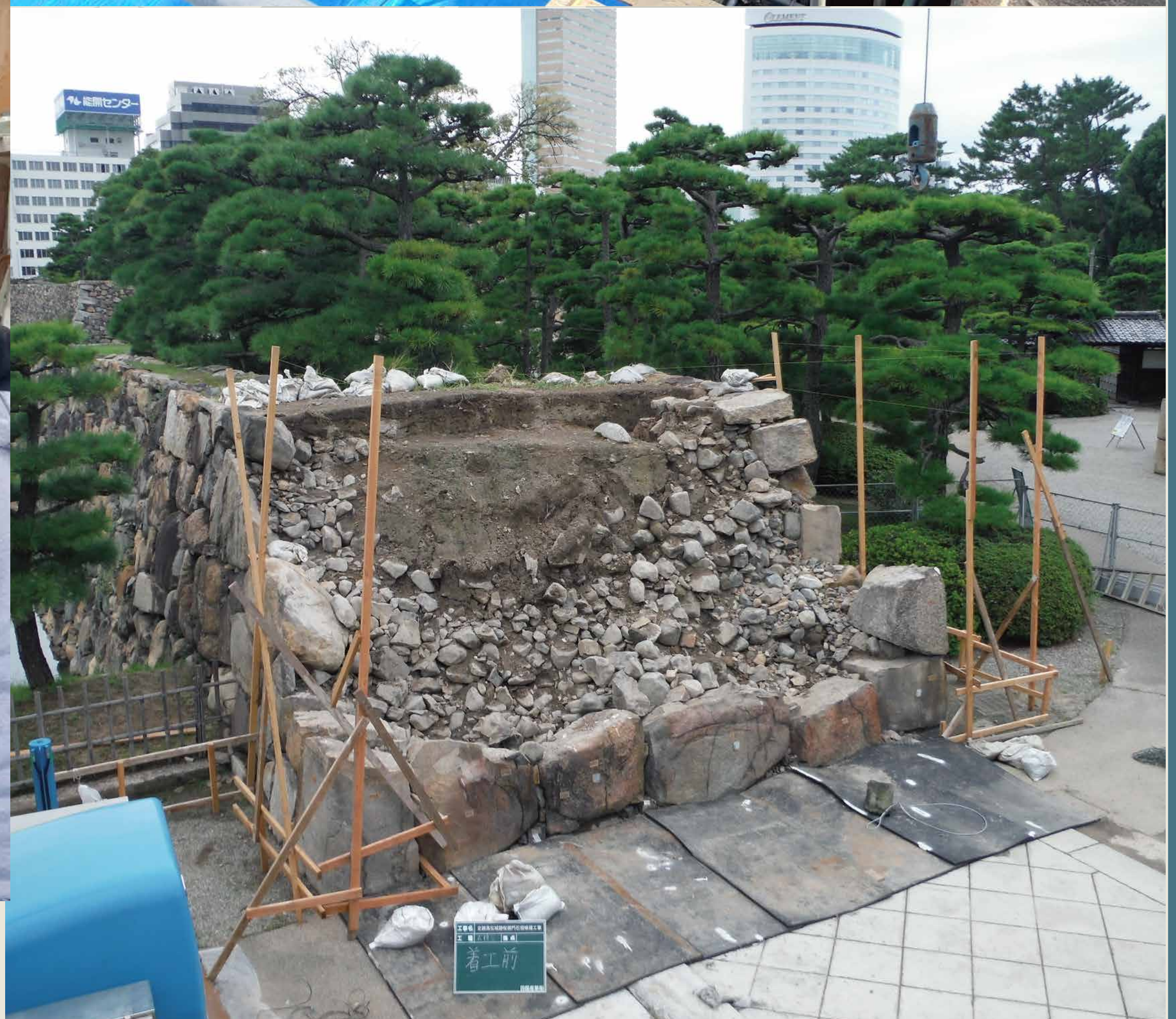
いしがき 石垣解体修理
