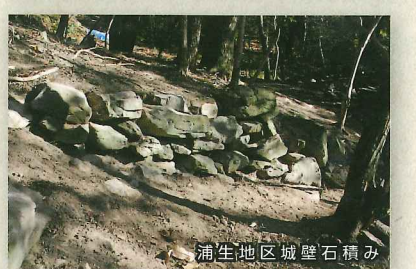
浦生地区城壁石積み
