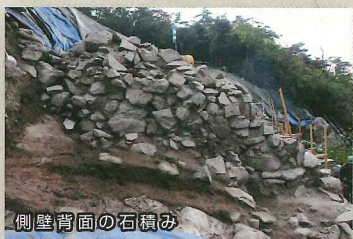
側壁背面の石積み
