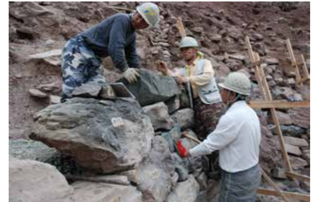
⑧石積み状況
