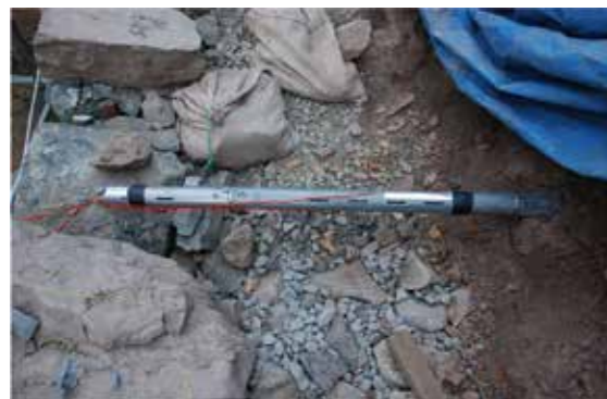
③歪み計設置状況
