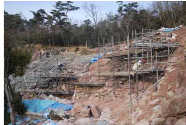
②解体前の状況
