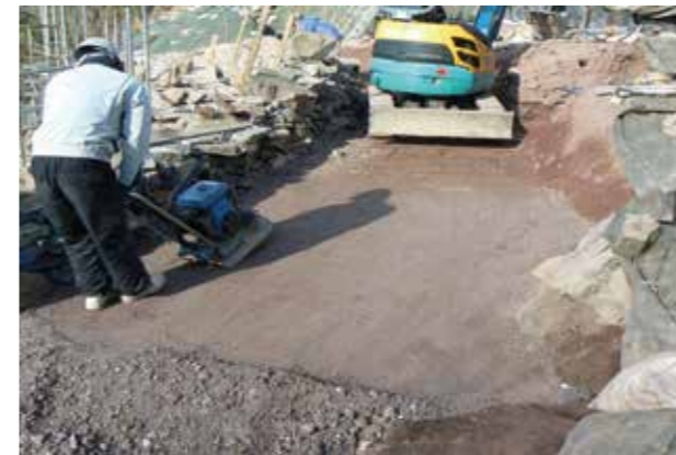
⑮盛土の転圧作業
