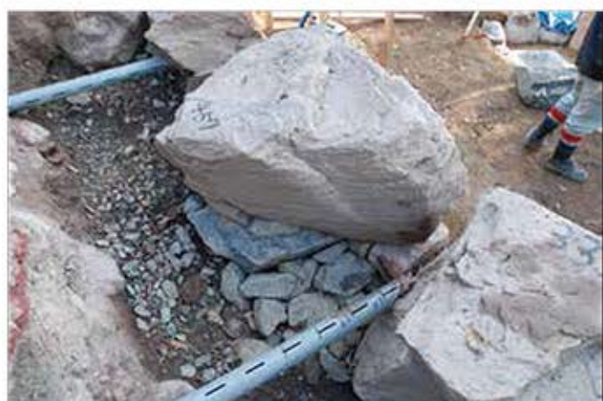
排水補強パイプ施工状況
