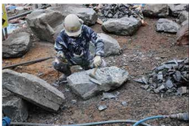
新補石材加工状況
