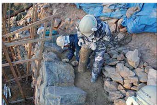
城壁施工状況
