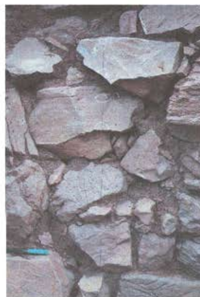
墨打ち後の状況
