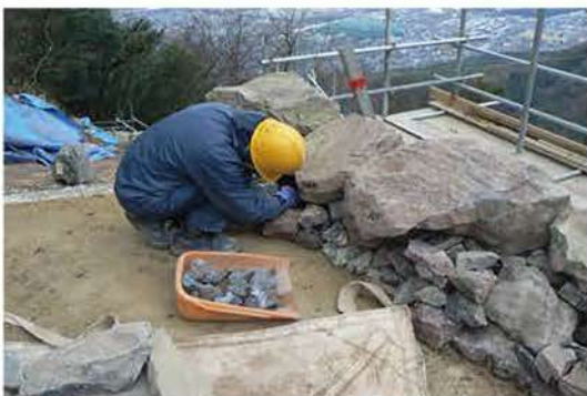
⑤飼石施工状況（その2）
