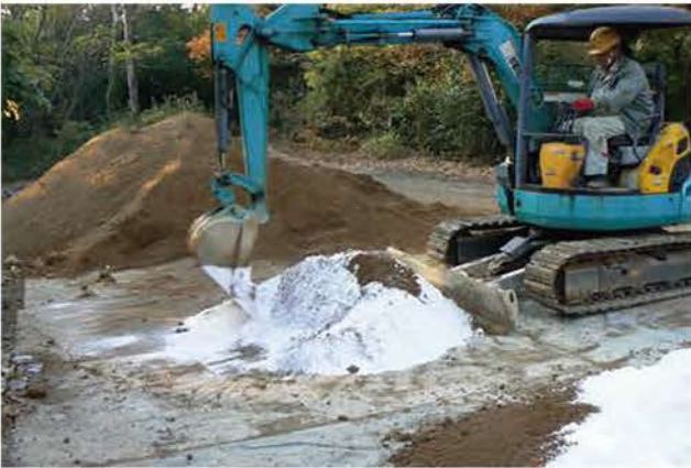
③攪拌作業（その1）
