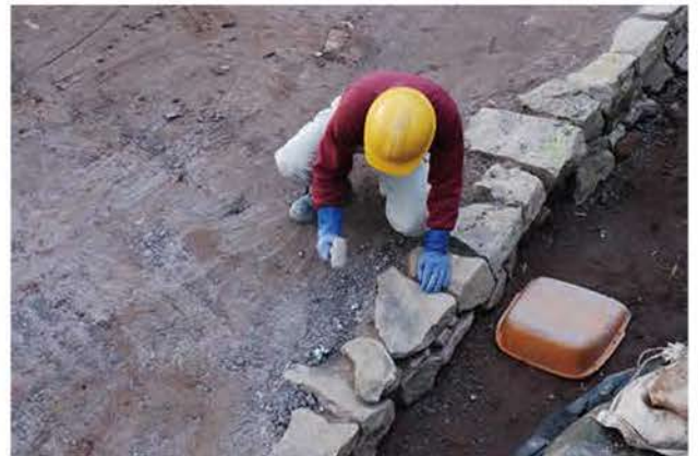
⑦人力による転圧作業
