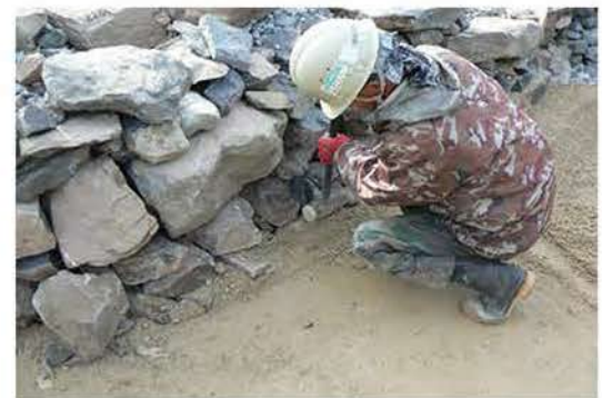
⑨築石背面盛土施工状況
