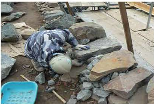
④飼石施工状況（その1）
