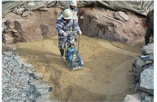
⑦転圧作業
