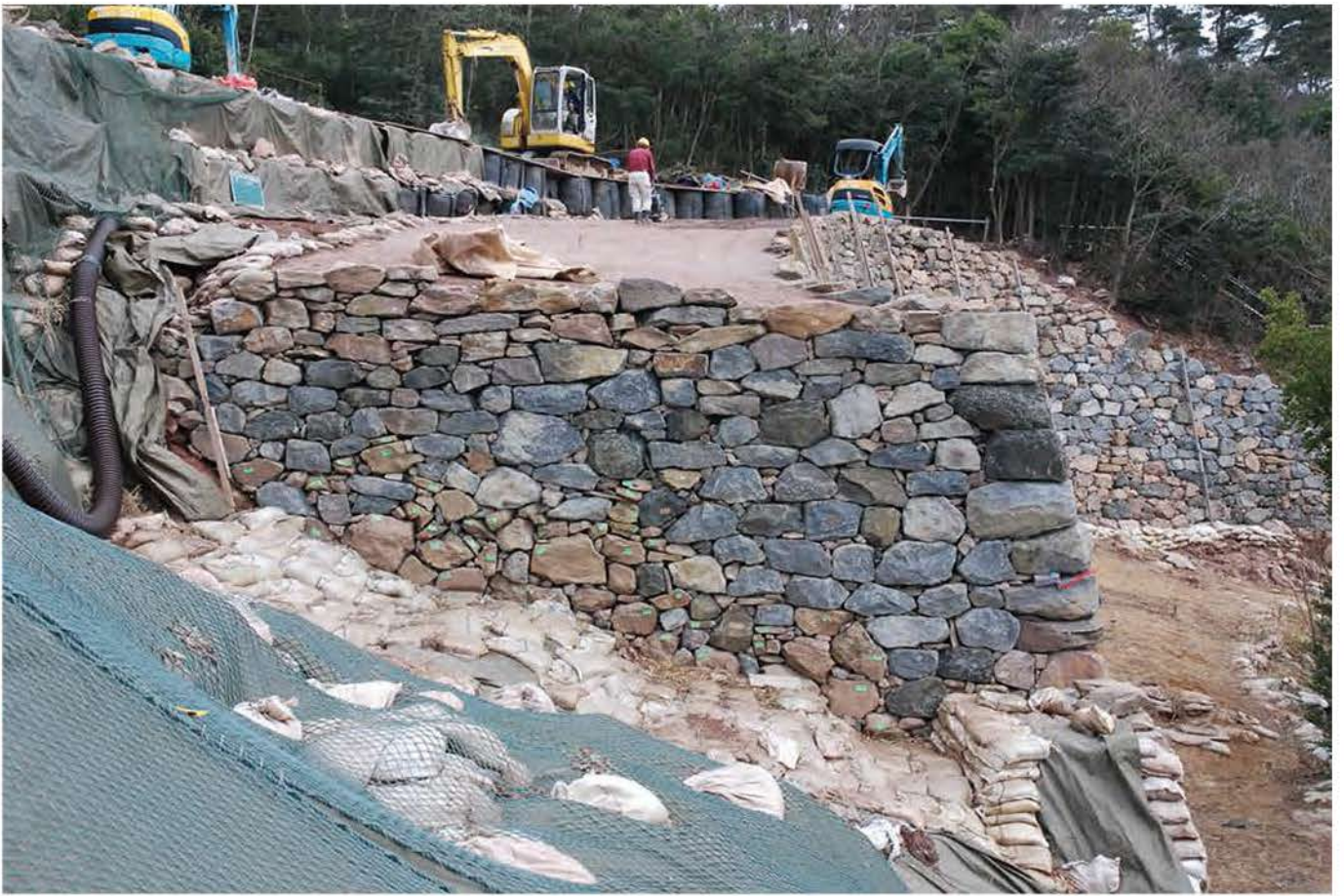
③ほぼ完成した城門側壁
