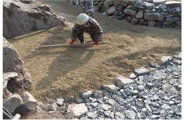
⑥敷き均し
