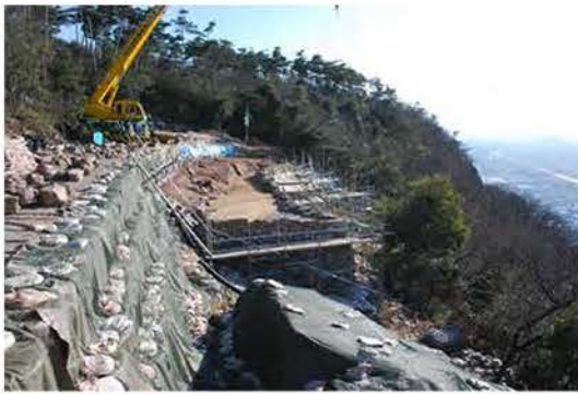
①施工状況遠景
