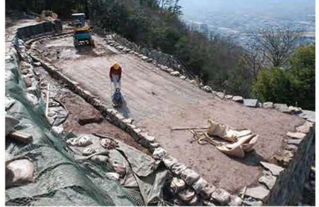
⑥転圧作業（その2）
