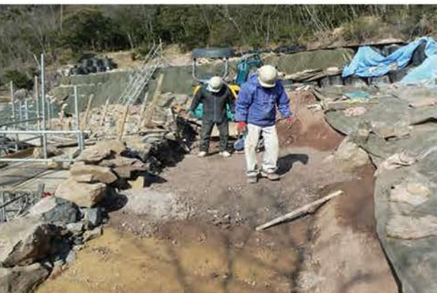
④人力による敷き均し
