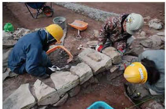
⑩背面列石施工状況
