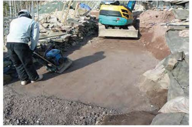
⑤転圧作業（その1）
