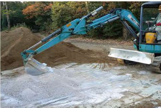
④攪拌作業（その2）
