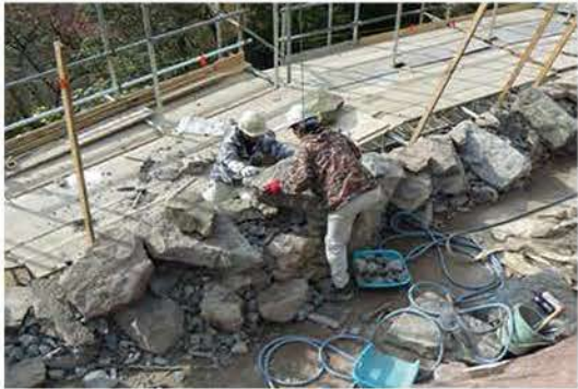
③石積み状況（その2）
