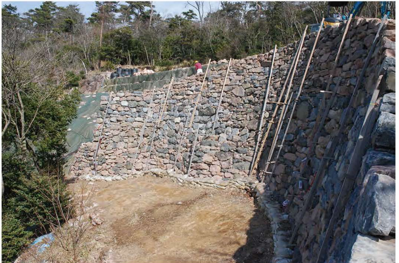
②ほぼ完成した城壁（その2）
