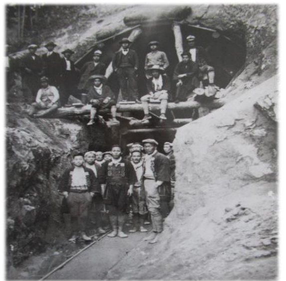
トンネル開通後の記念写真
