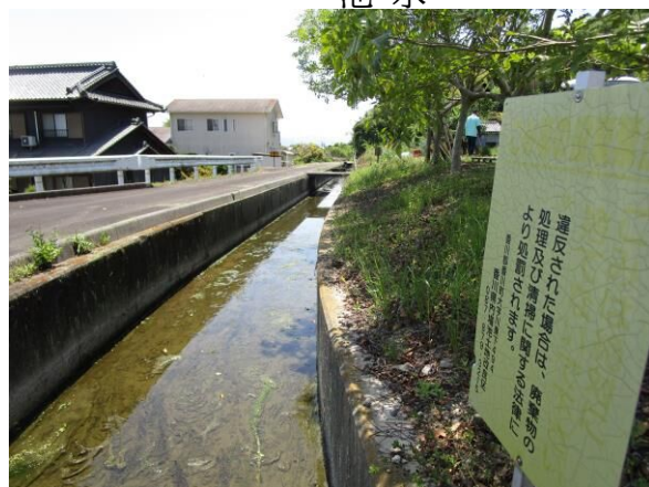
北岡城跡近くの本津幹線水路
