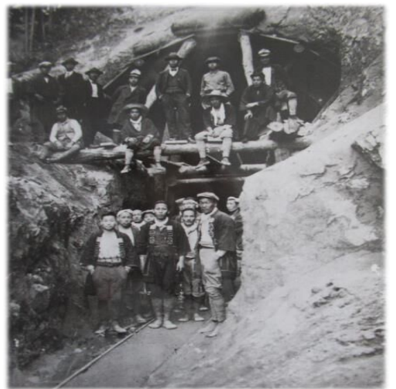
トンネル開通後の記念写真
