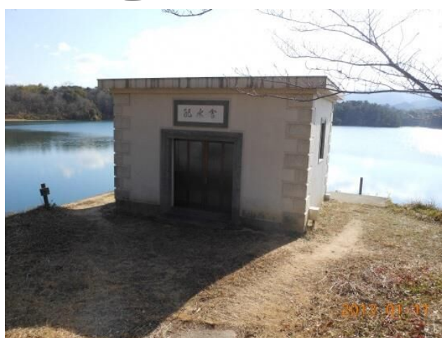
近代的な配水舎の建物
