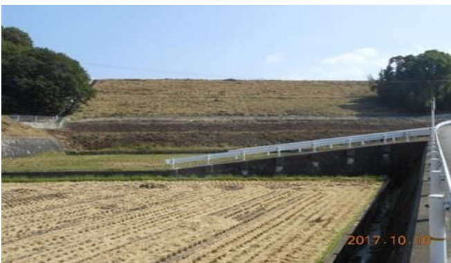
堤防の高さ28m、長さ260mある
