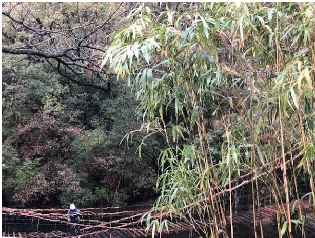
かずら橋架け替え作業の様子
