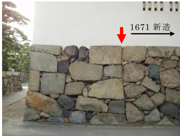
渡櫓の石垣継ぎ足し痕跡
