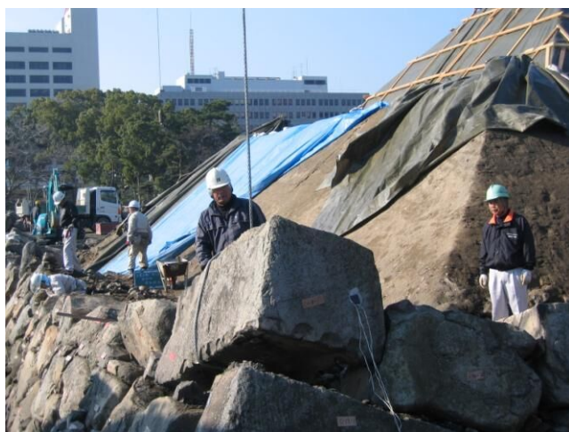
天守台石垣解体修理
