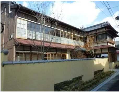
南西側から見た建物
