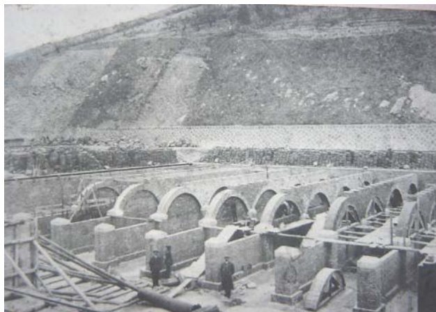
【西方寺配水池工事風景】
