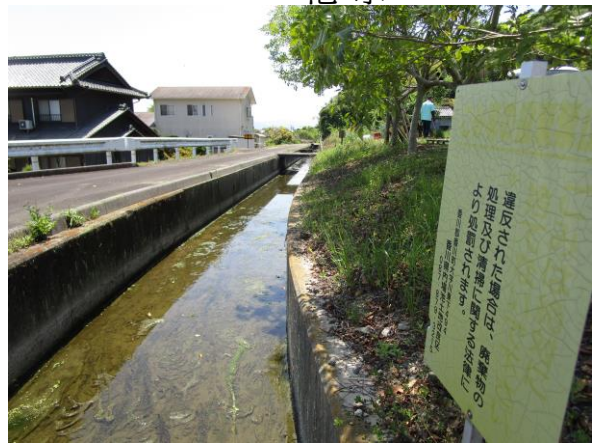
北岡城跡近くの本津幹線水路
