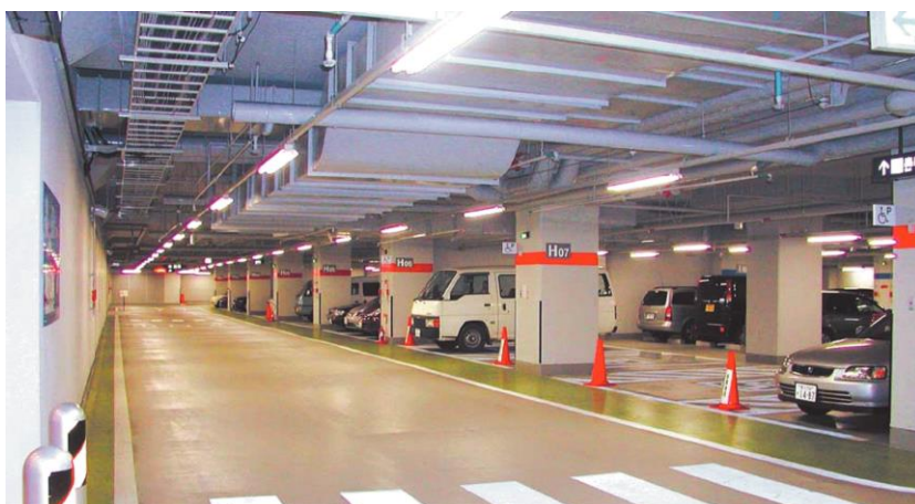
サンポート地下駐車場（高松駅前広場地下駐車場）
