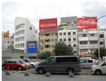
屋外広告物が建ち並ぶ JR高松駅前
