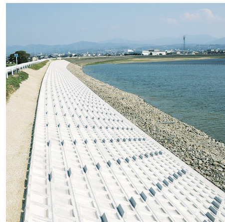
ため池の改修
