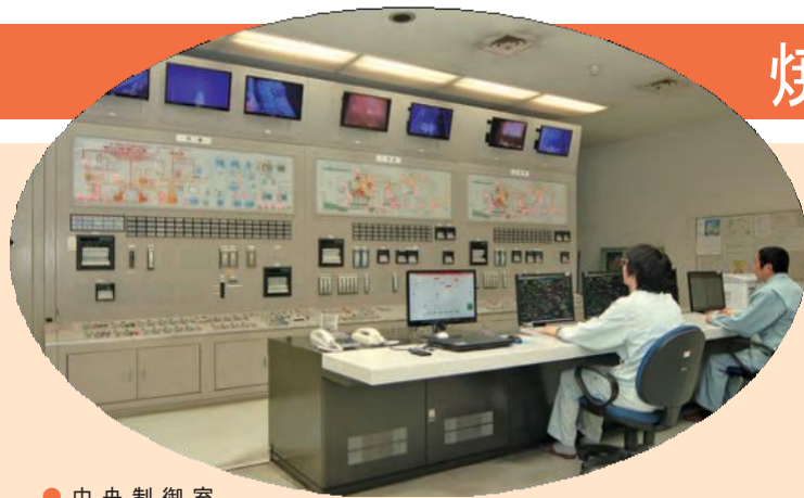
● 中央制御室 焼却炉の運転操作 公害防止機器の監視制御などを行います。
