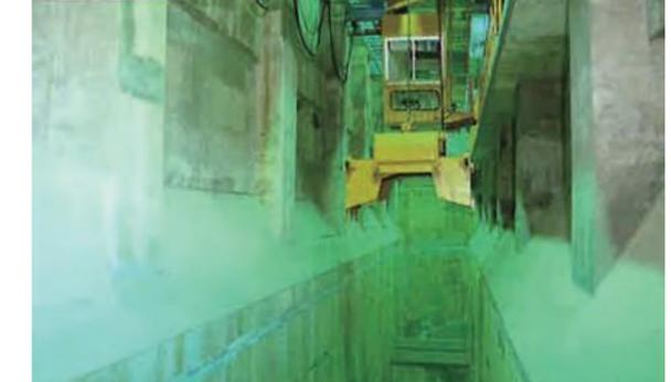
焼却灰は一旦ピットに貯留したのちに、灰クレーンでトラックに積み込み、最終処分場へ運ばれます。
