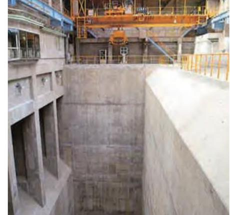
ごみピット内に一旦貯留したごみはごみクレーンで攪拌し、投入ホッパーから焼却炉に投入します。
