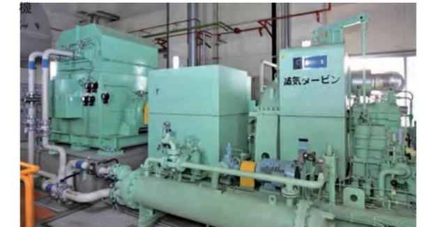
焼却熱で発生させた蒸気を利用した蒸気タービン発電機で発電し、施設で利用します。
