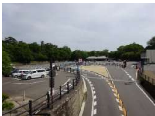
第1駐車場 外観
