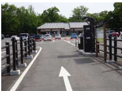
第1駐車場入口
