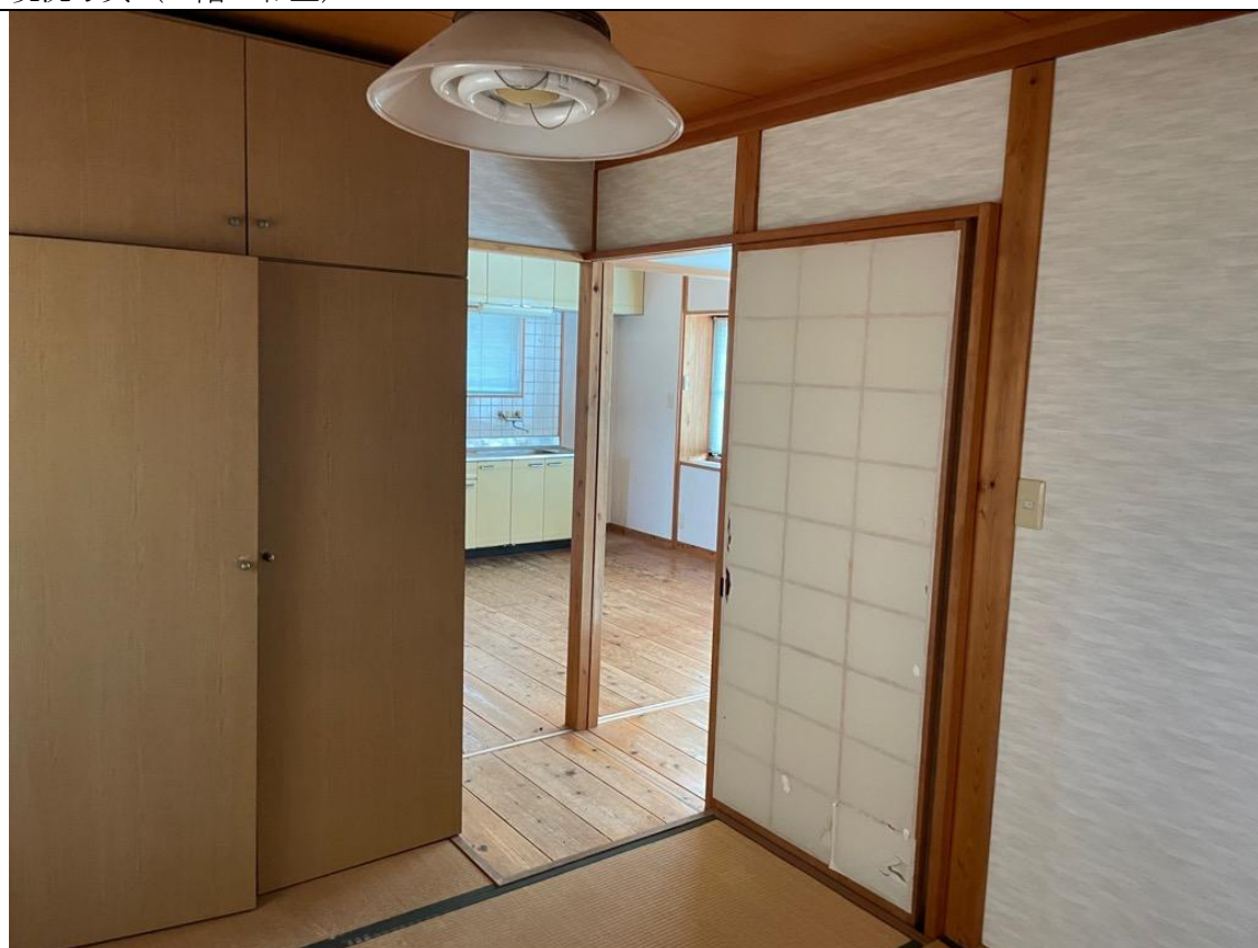
現況写真（2階 和室）
