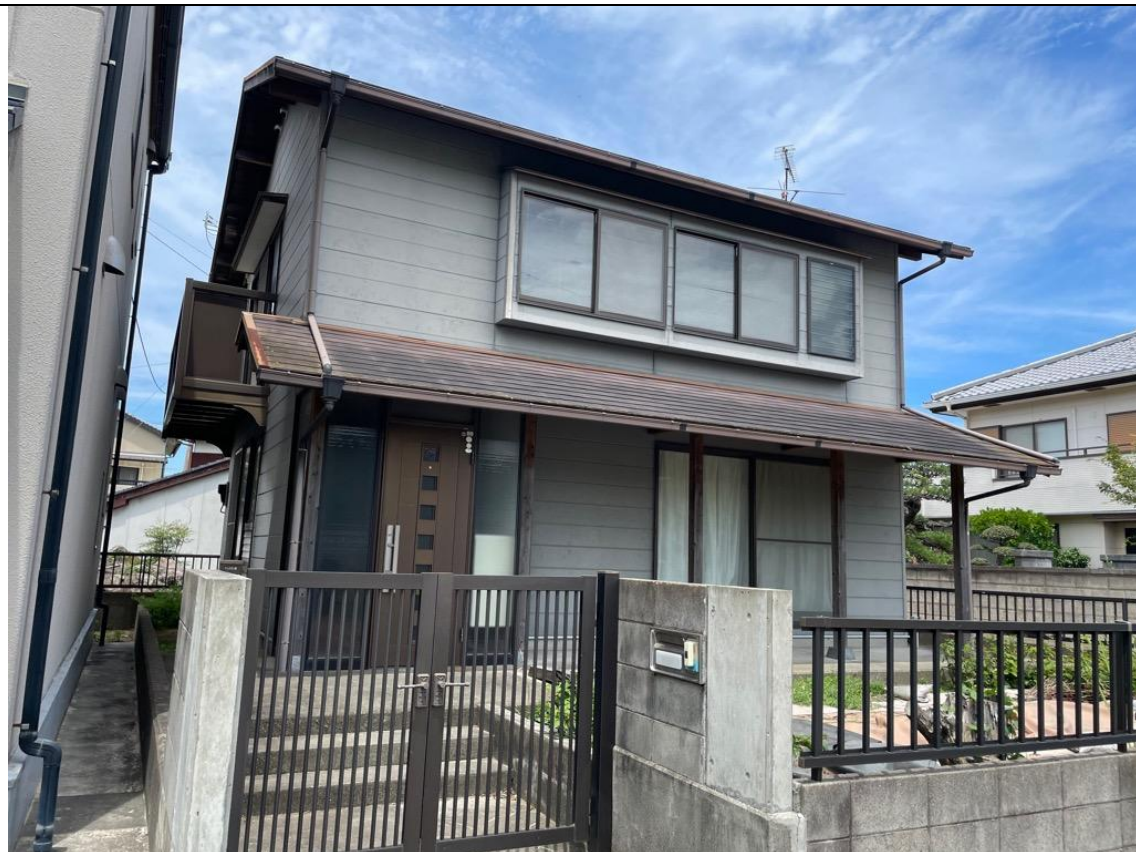
現況写真（居宅、南東方から撮影）
