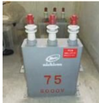
電力用コンデンサー
