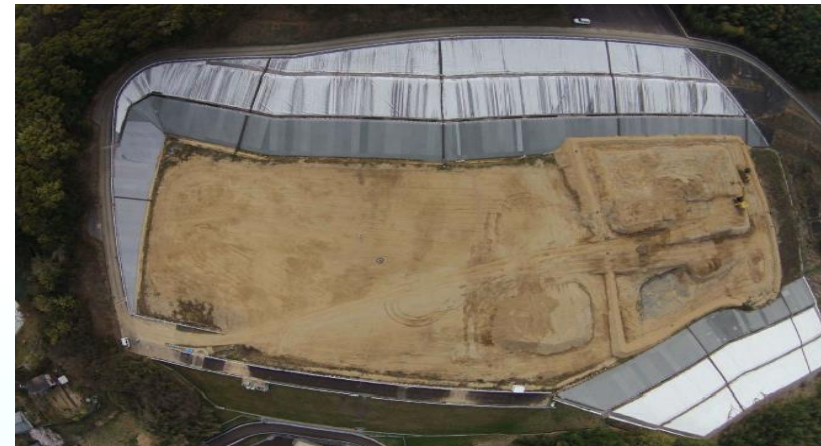
高松市一般廃棄物陶最終処分場（第3処分地）
