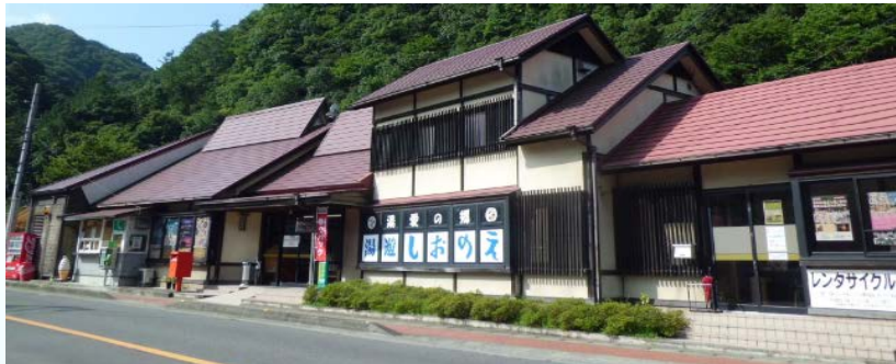
再整備を予定している道の駅しおのえ
