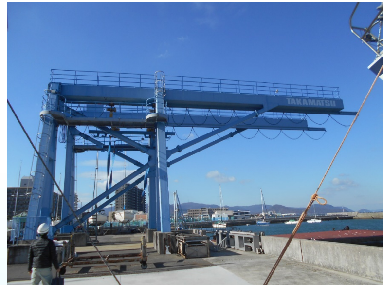
ヨット競技場クレーン
