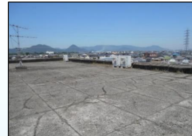
老朽化による屋上コンクリートや便所壁の亀裂
