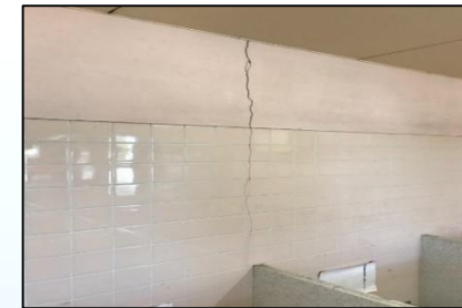
老朽化による屋上コンクリートや便所壁の亀裂
