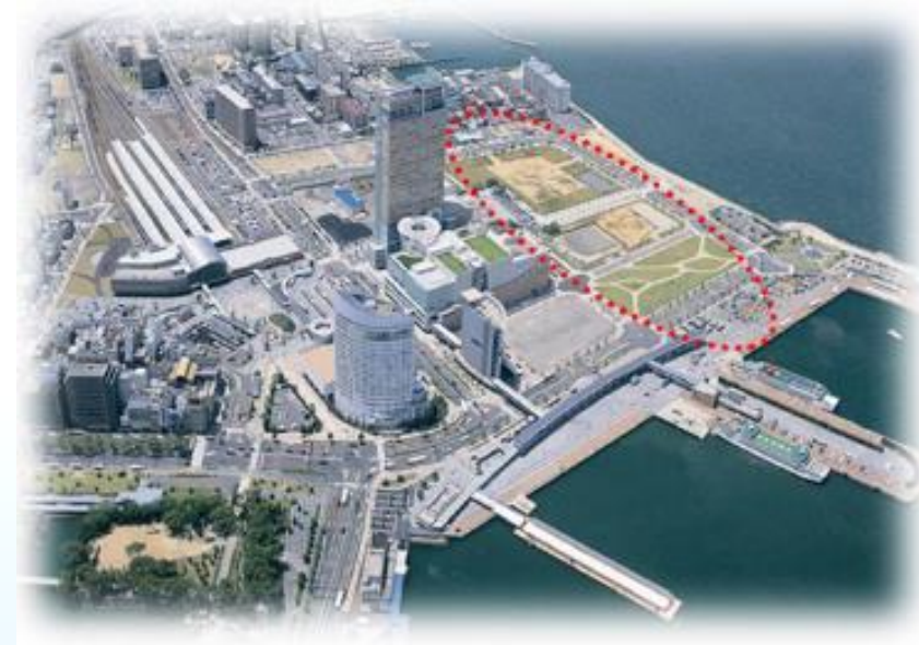
新県立体育館整備用地（点線部分）
