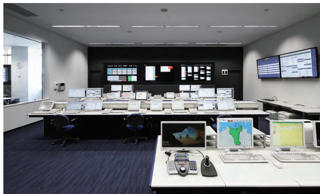
指令管制室（消防局）
