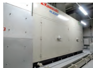
自家発電設備 (1000kVA) 72 時間運転が可能
