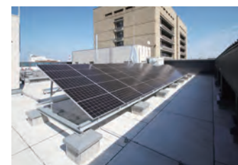
太陽光発電 (20kw) 自立運転にも対応
