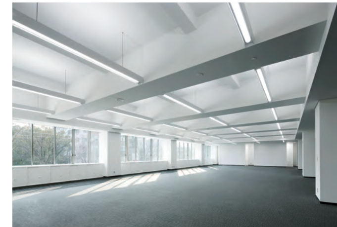
床輻射空調と照明バーにより天井高さとも明るさ感を確保し耐震安全性にも優れた執務室天井
