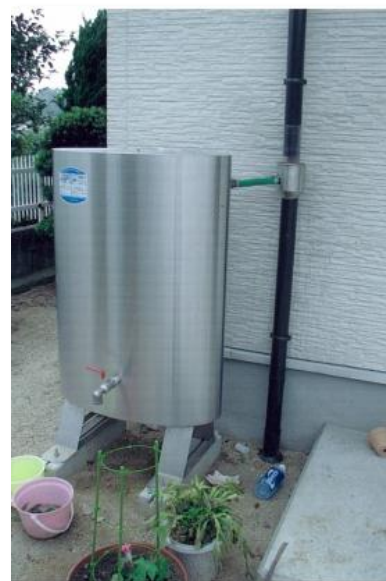
雨水貯留タンク
