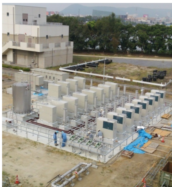
東部下水処理場 バイオマス発電
