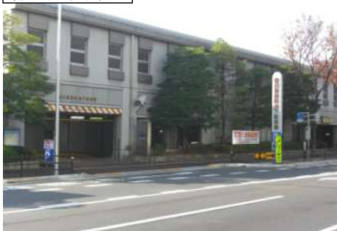
番町地下駐車場
